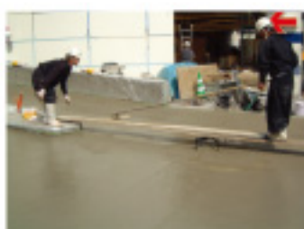
② コンクリート均し
