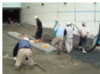
① コンクリート打設
